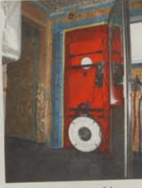
Meetapparatuur test of de aangebrachte isolatie zal volstaan.
