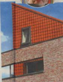
Een gevel kan je extra isoleren en afwerken met pannen. Foto: Koning
