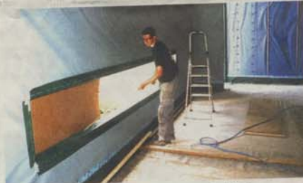
Het is belangrijk dat isolatie aan de binnenkant luchtdicht is. Foto: Kees
