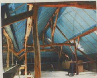
Nieuw bij dakisolatie is de intelligente damprem die qua vochtregulering rekening houdt met de seizoenen.
